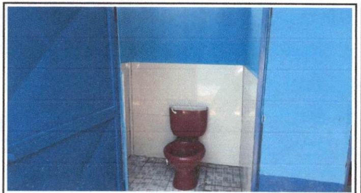
Foto 4: Instalación de tubería para sanitarios.
