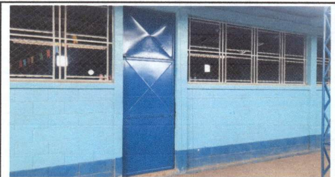
Foto 5: Remozamiento de puertas lijadas unidad y pintado.
