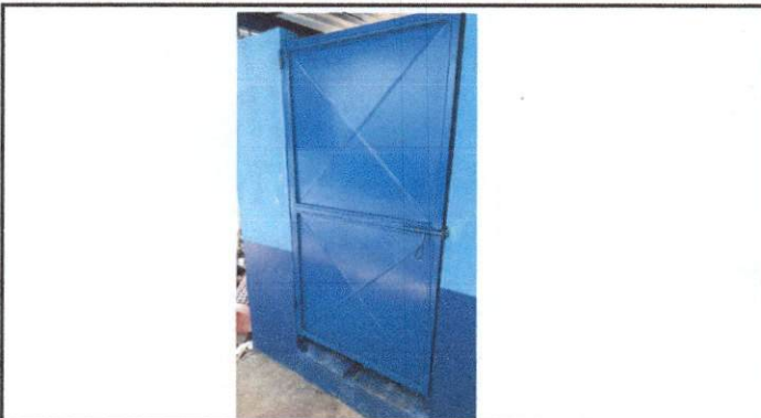
Foto 3: Instalación de puerta de metal.
