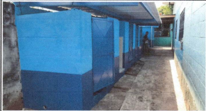
Foto 1: Mejoramiento de estructura portón de suministro de costanera tipo C lijado y pintado.
